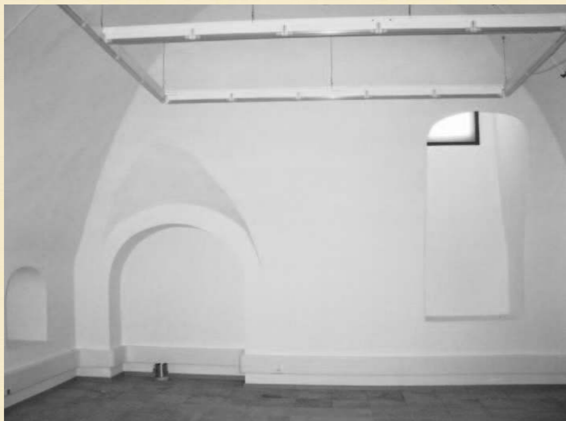
Белокаменный подвал северного ризалита отреставрирован в 1996–1997 годах
