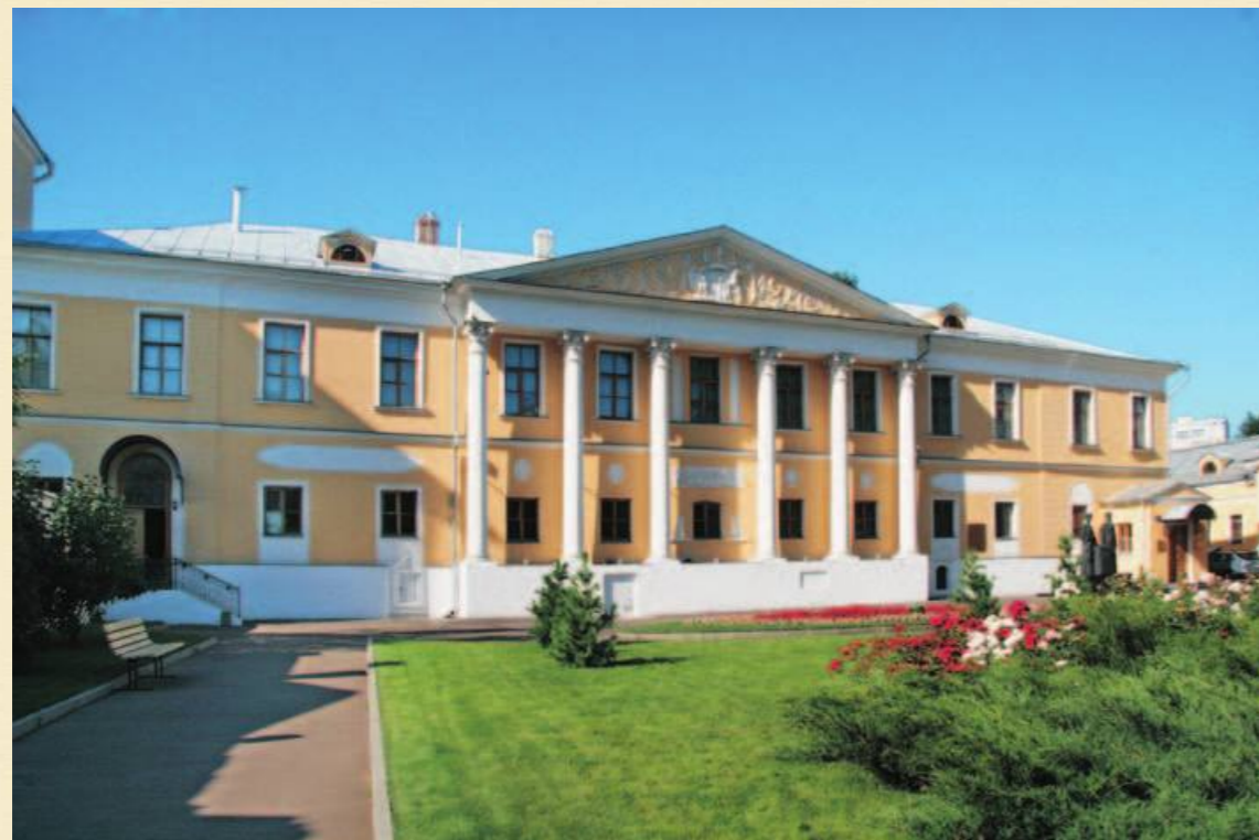
Реставрация главного фасада завершена в 1996 году
