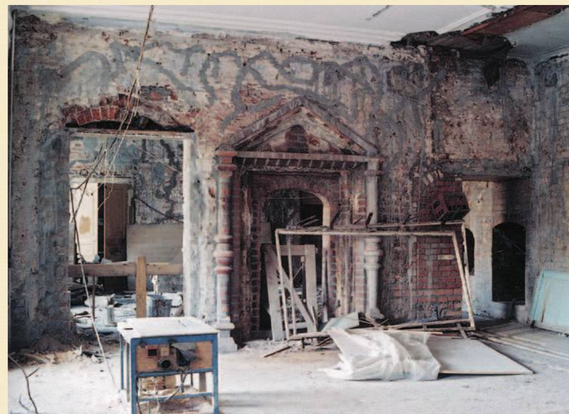
Зал восточной анфилады второго этажа в процессе реставрации. 1995
