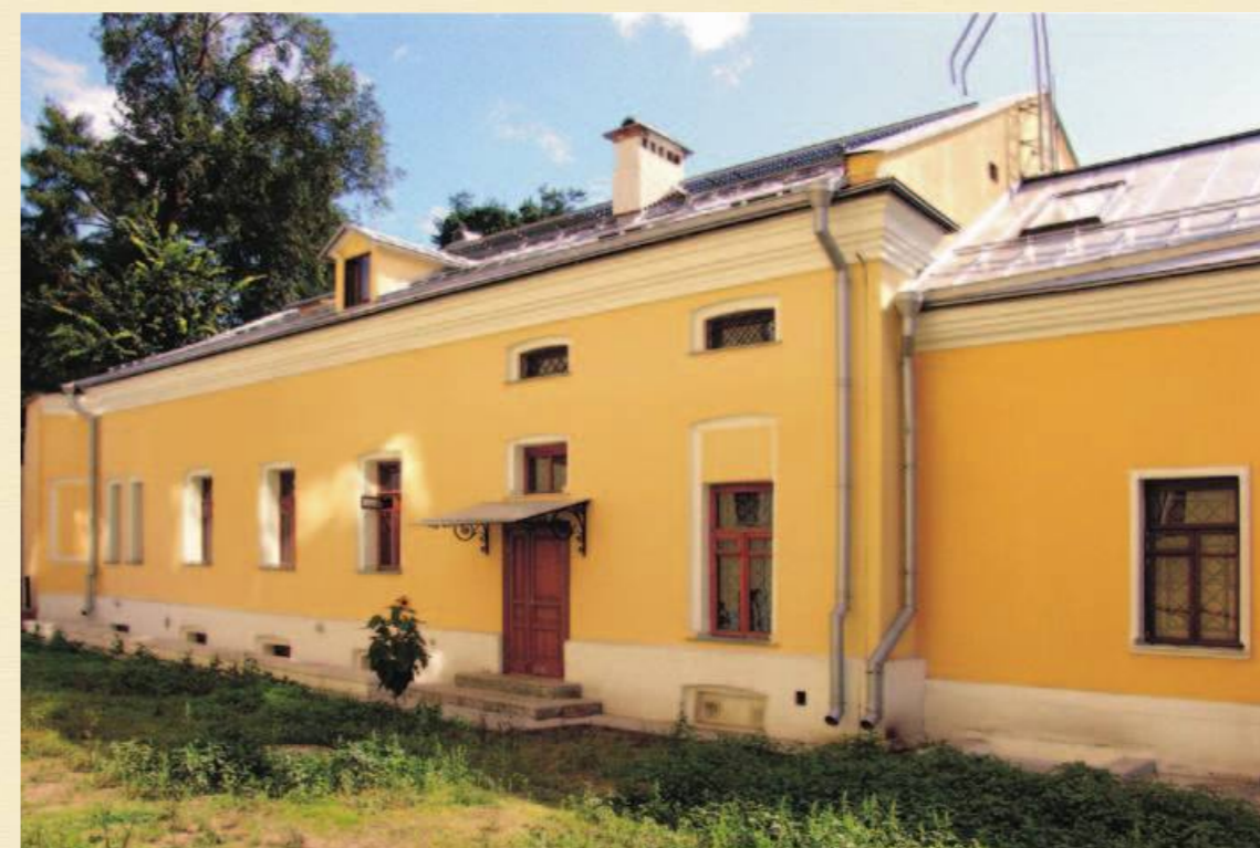
Фрагмент дворового фасада. 2004
