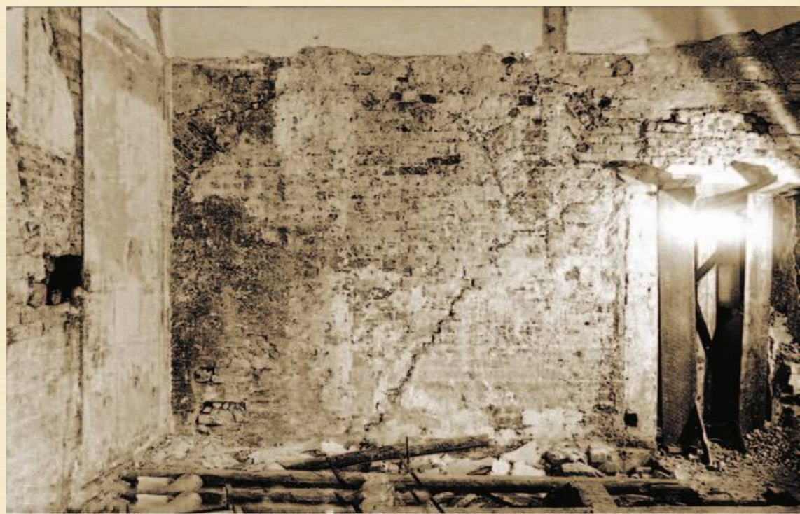
Зал западной анфилады второго этажа. 1995
