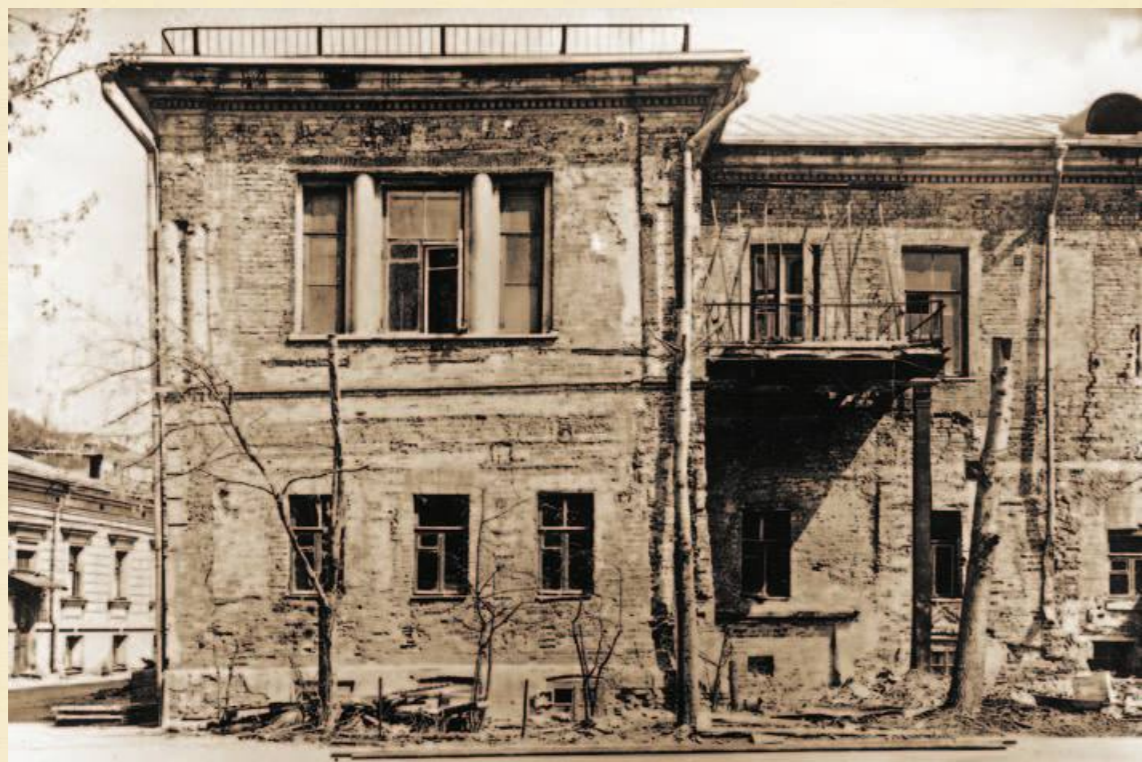
Фрагмент левого крыла дворового фасада. 1980-е годы
