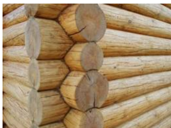
Рис. 4. Врубка бревен в чашу
