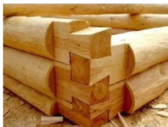
Рис. 5. Врубка бревен в лапу
